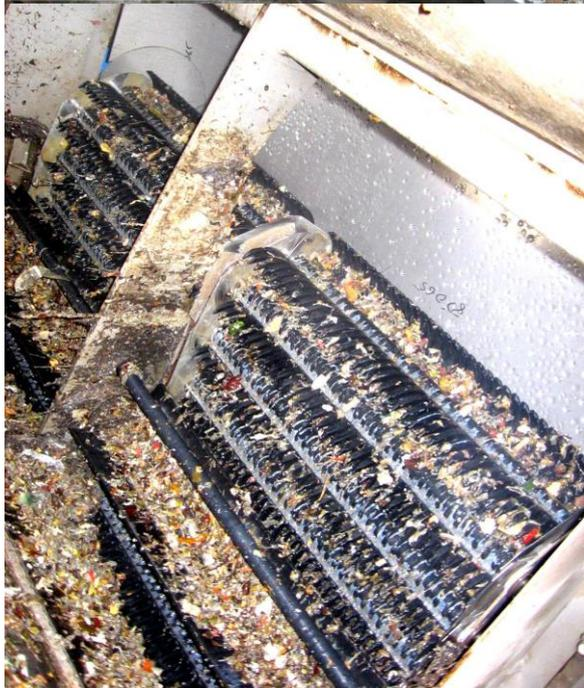
Возможность быстрой установки и надежная эксплуатация позволяют использовать решетку AQUA-DAKT для всех видов каналов. Поставляемые размеры: 300 до 3000 мм шириной и от 1 до свыше 12 м высотой.
